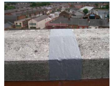
护墙和压顶石接缝
